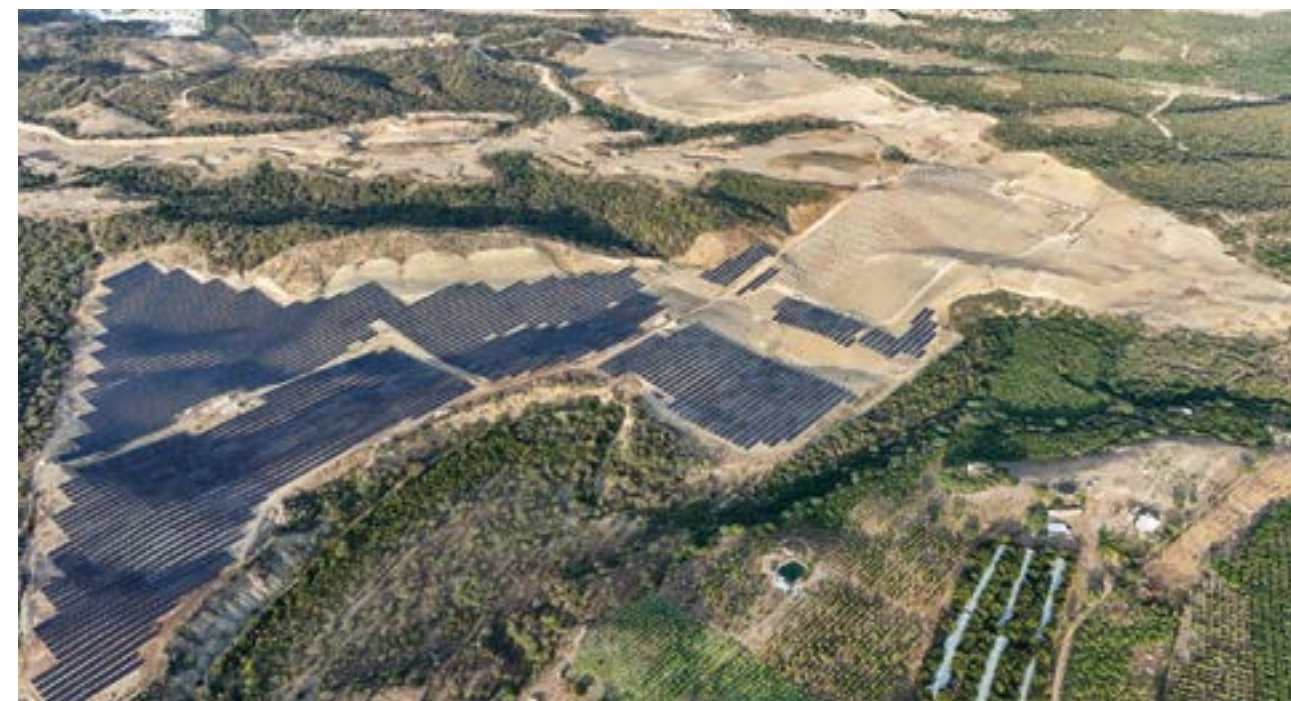
PLANTAS FOTOVOLTAICAS PERAVIA I Y II 180 MW (REPÚBLICA DOMINICANA)
